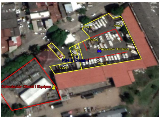
Ilustración 6. Área Parqueadero Subestación Diesel I
