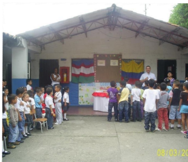
Figura 2. Instalaciones de la I.E. Eustaquio Palacios sede Celanese Fuente: Elaboración propia.
