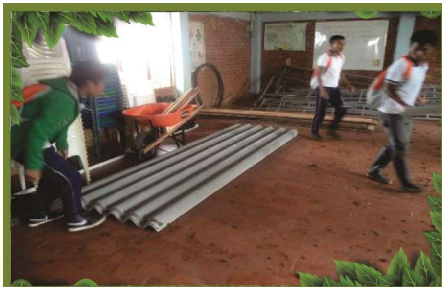
Foto 14: Recibiendo material para mejoramiento de infraestructura El Credo. Año 2015
