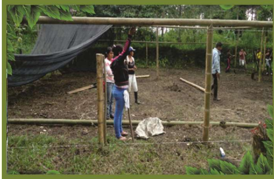
Foto 10: Vivero Escolar de Toez año 2012, construcción de nuevas áreas.
