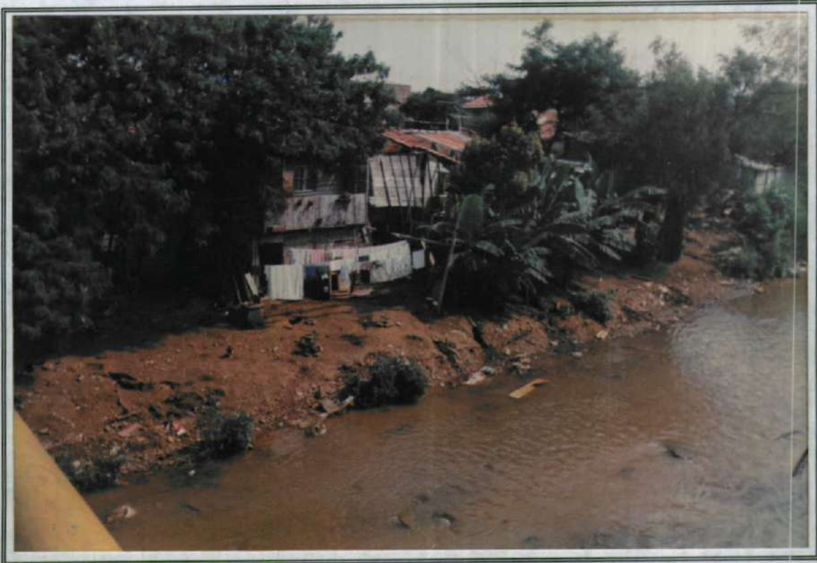
FOTOGRAFIA C28 Vista aguas arriba puente de la calle 44. Asentamiento la Isla.
