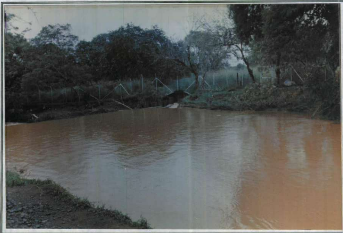
FOTOGRAFIA M5 Calle 4, Barrio Meléndez, Antiguo Dique toma del Ingenio Meléndez. Obsérvese el canal de aducción al fondo, época invernal.
