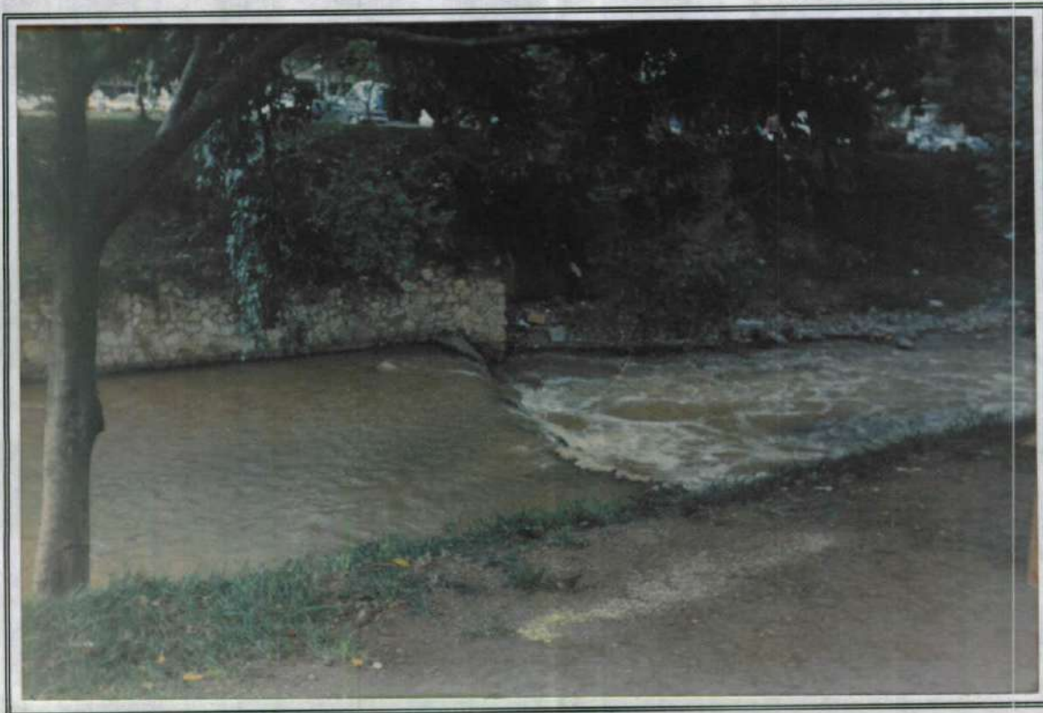
FOTOGRAFIA C25 Calle 19N - Inicio del tramo sin muro a ambos lados.
