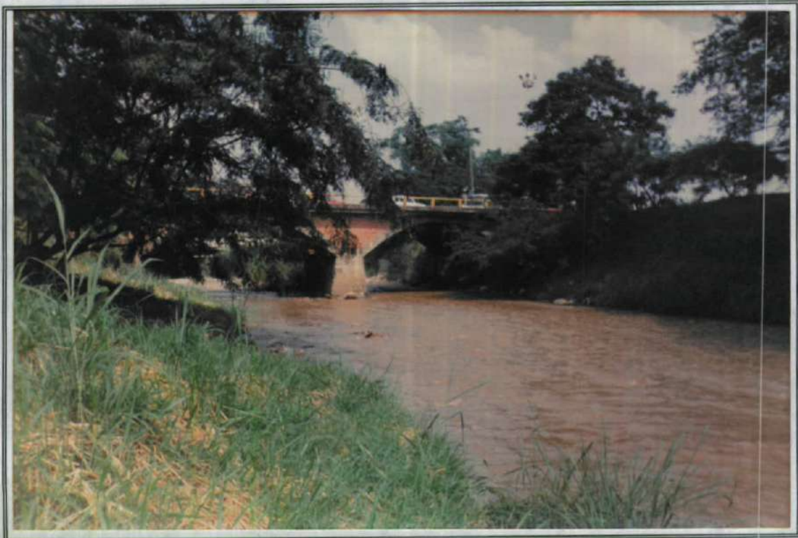
FOTOGRAFIA C27 Puente sobre la Clínica de los Remedios.
