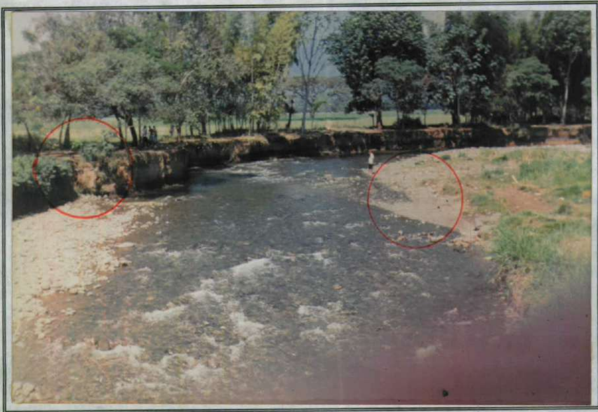
✓ FOTOGRAFIA P 20 Erosión de margen derecha del río en La Viga, alta probabilidad de inundación hacia la margen izquierda.
