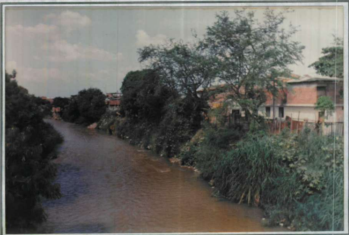
FOTOGRAFIA C29 ✓ Vista aguas abajo, puente de la calle 44. Asentamiento la Isla.
