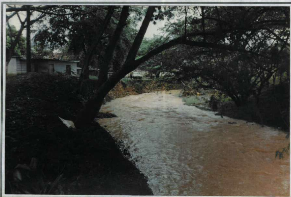
FOTOGRAFIA M8 Erosión orilla izquierda, agua abajo Dique toma del Ingenio Melendez.
