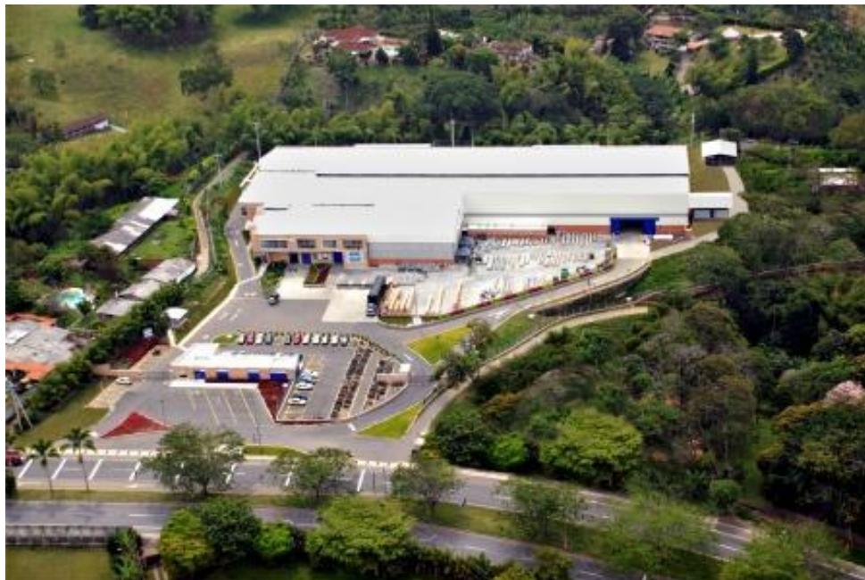
Imagen 3. Instalaciones principales de Magnetron S.A. Km 9 vía Pereira-Cartago
