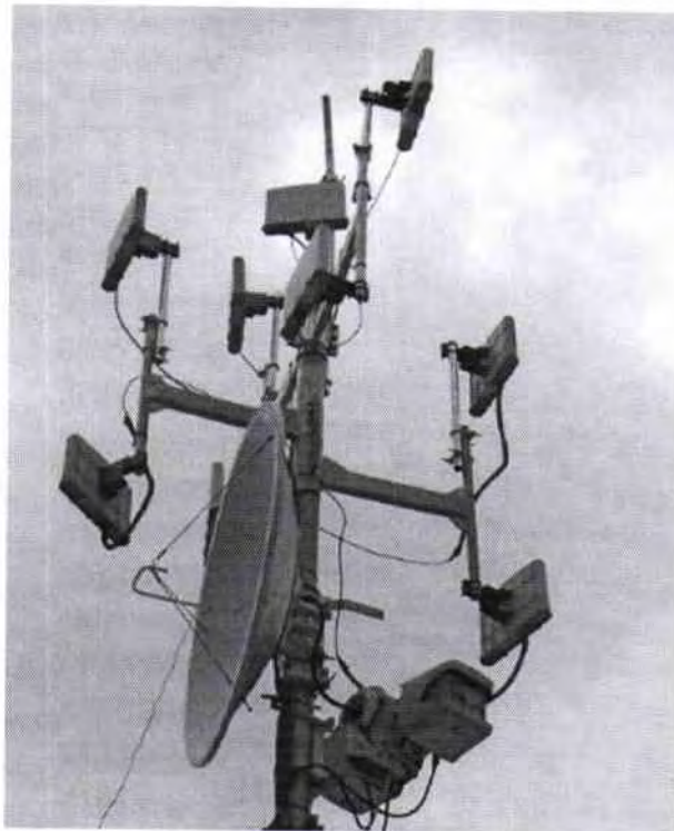
Figura 17. Estado Final BSRs después de la reubicación
