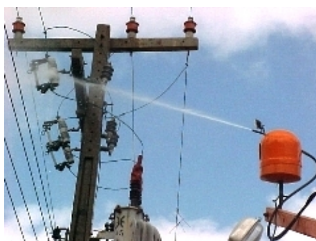
Figura 2. Primer proceso automatizado de limpieza
